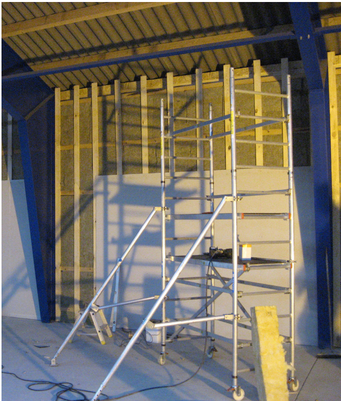
Januar og februar gik med at isolere 2/3 dele af hangaren. Sidste 1/3 del er planlagt til vinteren 2020/2021.
